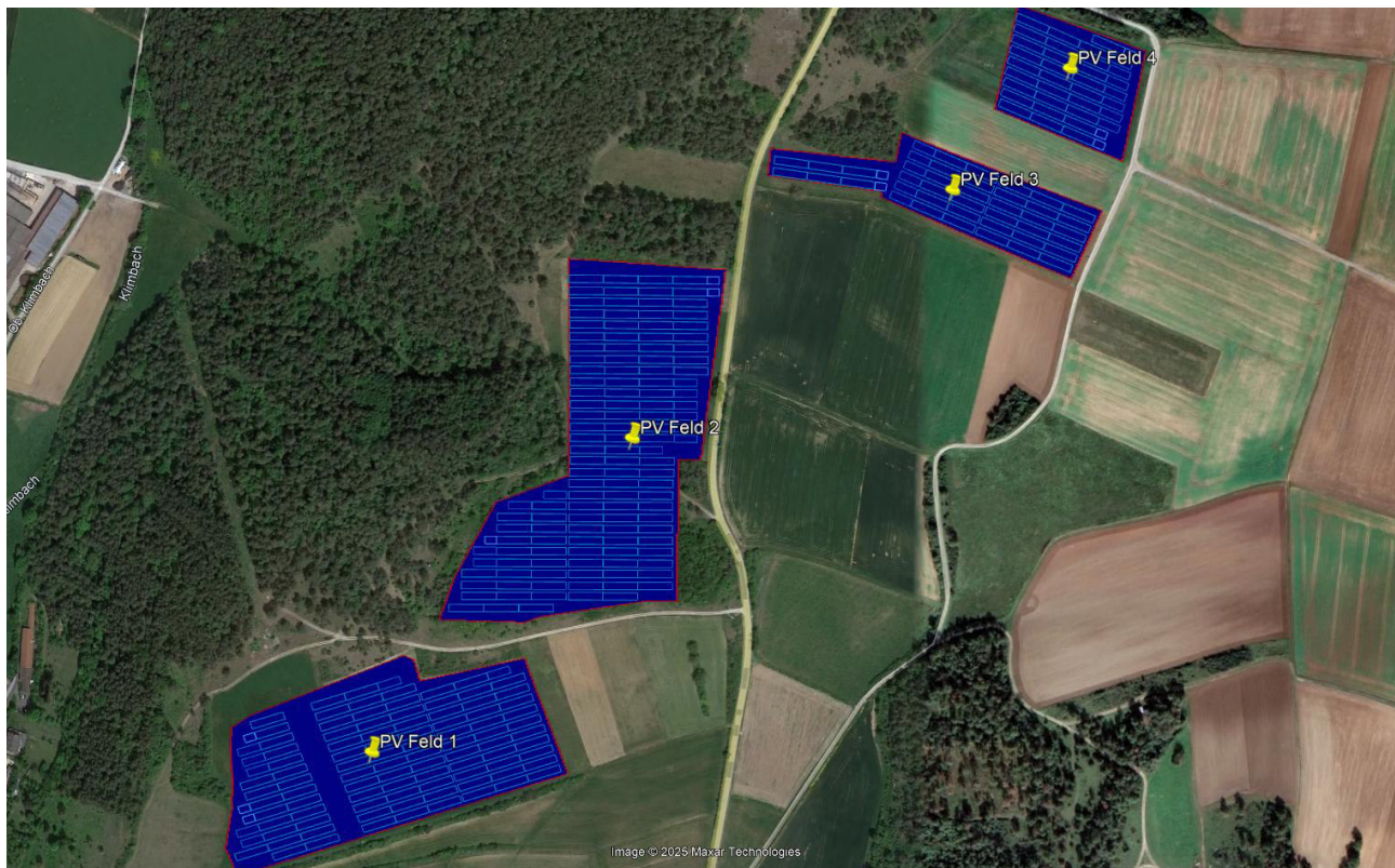
Bild 2.3: Luftbild der PV-Anlage (Quelle: Google Earth / SolPEG)
